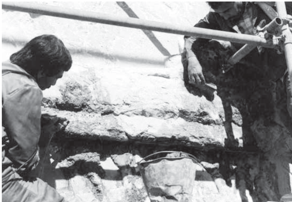
تصویر ۳. مرمت‌گران بنیاد پژوهشی پارسه - پاسارگاد در حال رسوب‌زدایی و پاک‌سازی سطح یکی از کتیبه‌های DNe در سال ۱۳۸۰ (تصویر از مرکز اسناد بنیاد پژوهشی پارسه).
